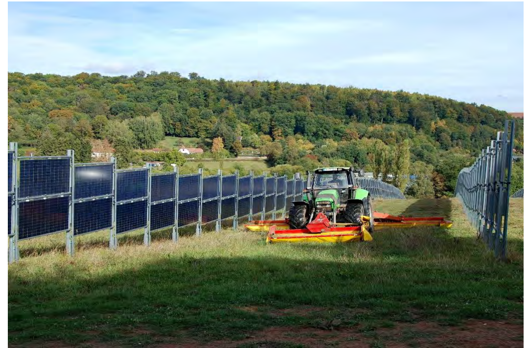
Abb.5. Vertikal bifaziales APV-System in Deutschland (Next2Sun GmbH, s.a.)
